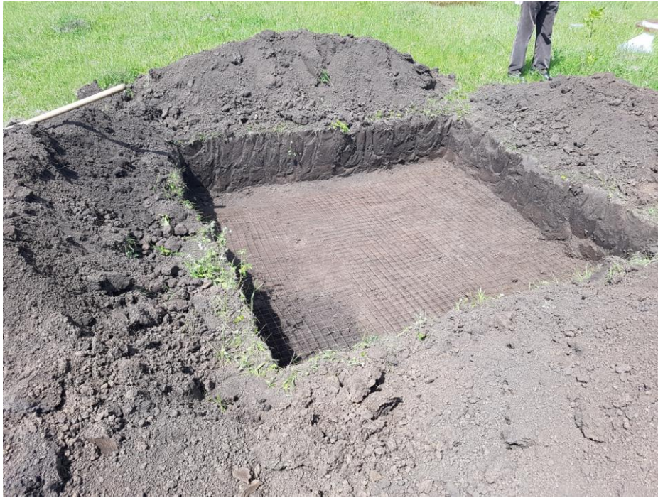
Рис. 3.19. Полость в грунте для размещения патч- антенны. Глубина полости – 0.5 м, ширина в обоих направлениях – 2.5 м. На дне полости расположена стальная сетка с размером ячейки 50 мм
