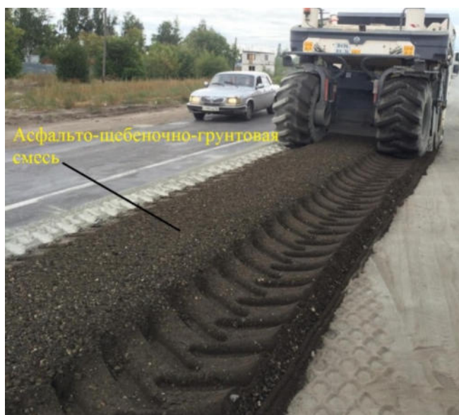
Рисунок 4.5 – Регенерируемый слой из асфальто-щебеночно-грунтовой смеси
