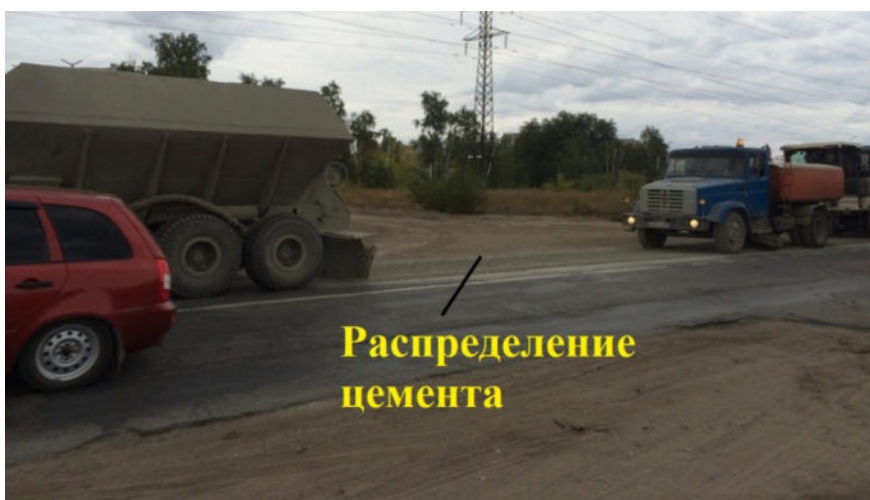
Рисунок 4.4 – Распределение цемента перед ресайклером в сухом виде непосредственно на существующее покрытие из расчета 30 кг на 1 м 2
