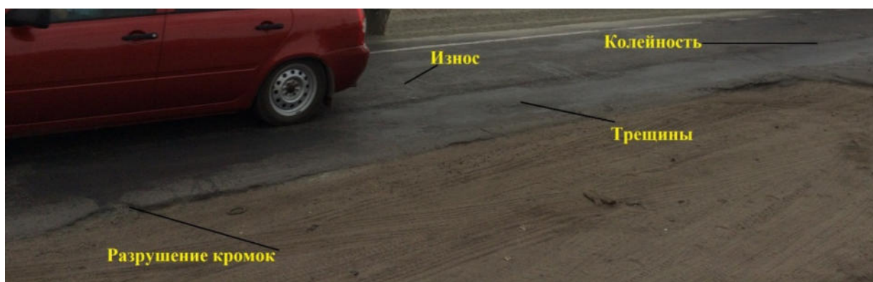
Рисунок 4.9 – Состояние покрытия до проведения ремонта
