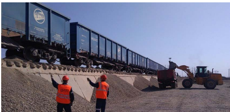
Рис. 1. Разгрузка щебня из полувагонов на эстакаде
