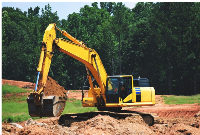
Рис. 1. Разработка грунта гидравлическим экскаватором с рабочим оборудованием обратная лопата
