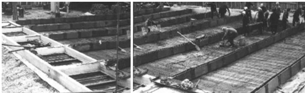
Рис. 2. Вид прикрепленных открылков и укладки арматуры
