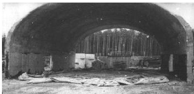
Рис. 4. Вид готового сооружения со снятой опалубкой
