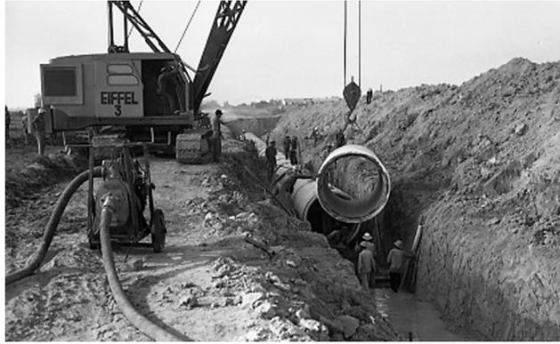
**Рис. 1.** Прокладка трубопроводов (двухслойные бетонные трубы, футерованные стальной трубой) диаметром 2000 мм от насосной станции Тху Дык (1966 г.) [1]
