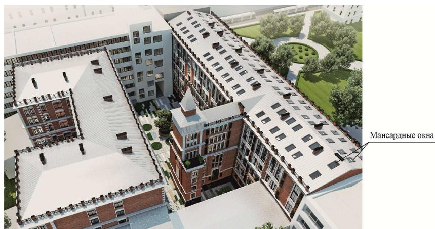
Рис. 2. Применение мансардных окон при реконструкции
