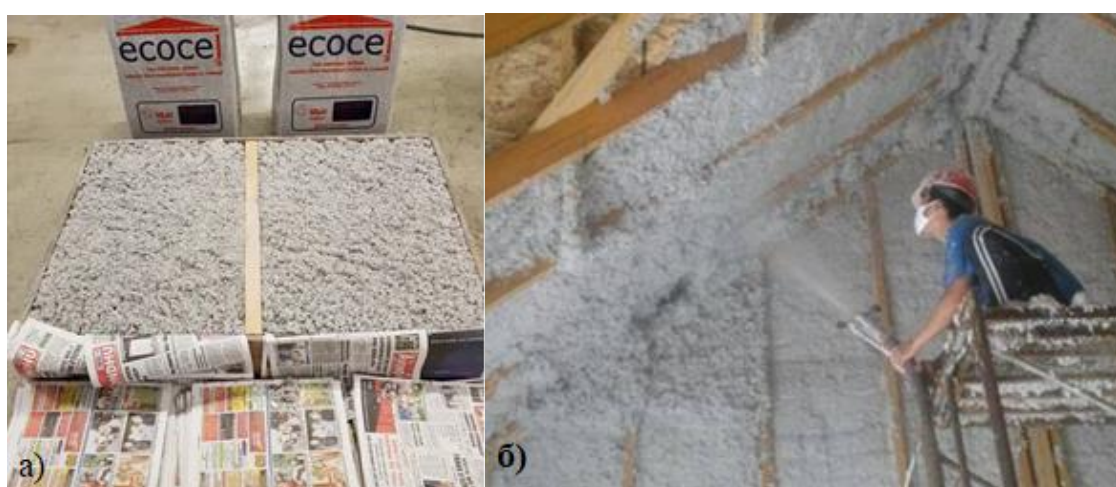
Рис. 3 – Изоляционный материал из целлюлозного волокна:
