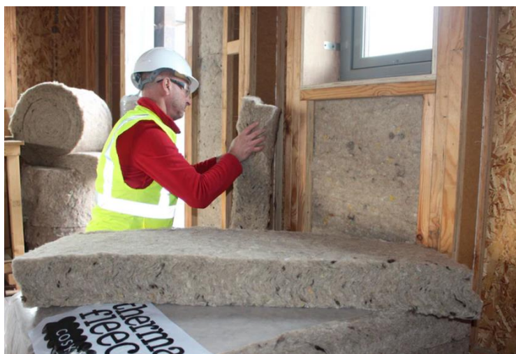
Рис. 4 – Монтаж рулонной овечьей шерсти
