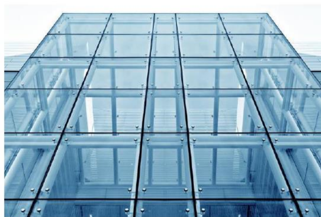
Рис. 4 - Спайдерное остекление
