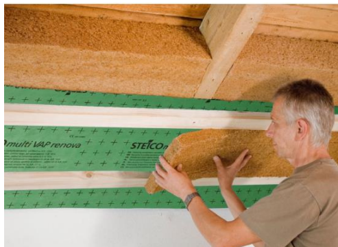
Рис. 1 – Монтаж теплоизоляционного древесноволокнистого материала
