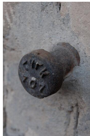
Рис. 3. Внешний вид стенового опорного репера
