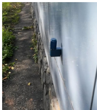
Рис. 4. Внешний вид деформационной марки
