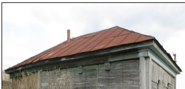
Рис. 3. Вид кровли объекта
