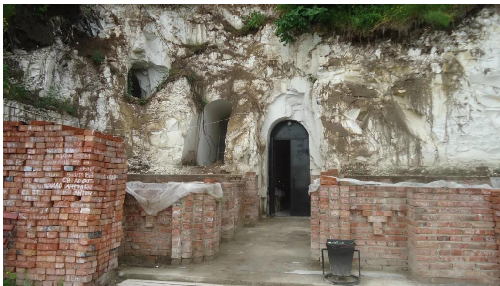
Рис. 1. Укрепление надвратной части пещеры
