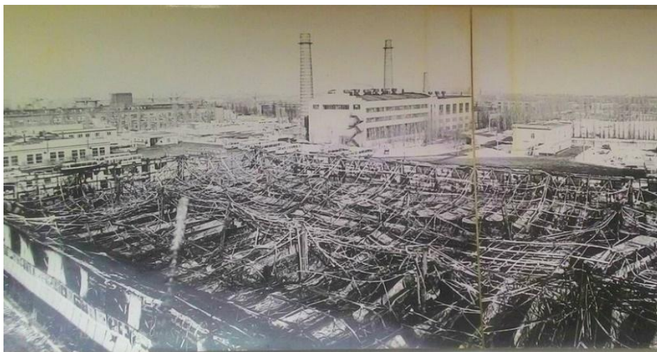
Рис. 5. Вид на гараж автотранспортного предприятия ПАТП-3 после пожара. Под стальными конструкциями видны остовы сгоревших автобусов
