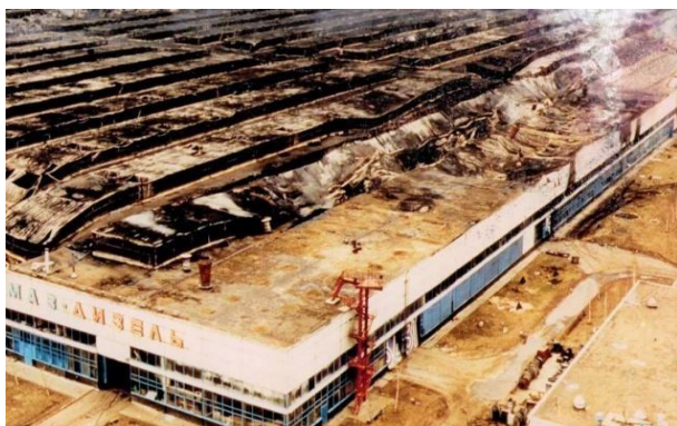
Рис. 3. Фрагмент панорамы завода двигателей после пожара
