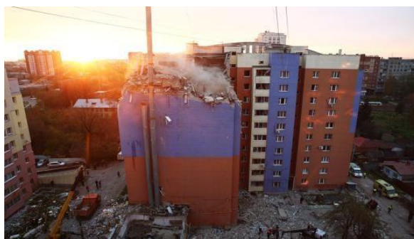
Рис. 4. Обрушение двухэтажного дома после взрыва бытового газа
