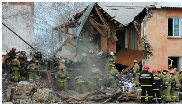
Рис. 3. Разрушенные верхние этажи жилого дома после взрыва бытового газа
