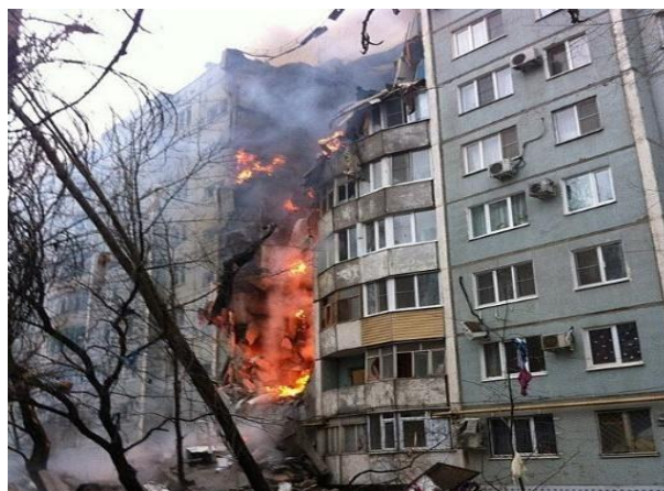
Рис. 7. Фрагмент подъезда после взрыва и последовавшего пожара
