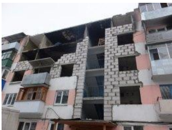
Рис. 7. Процесс восстановления дома после взрыва и последующего пожара
