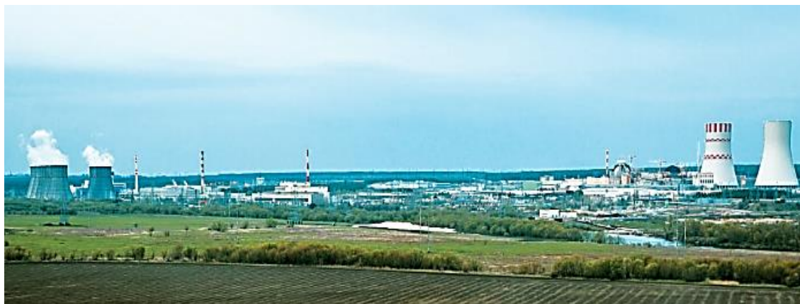
Рис. 1. Нововоронежская АЭС-2 (блок №6 НВ АЭС)
