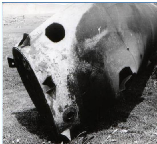
Рис. 3. Фрагмент башни с вырезанными кусками металла
