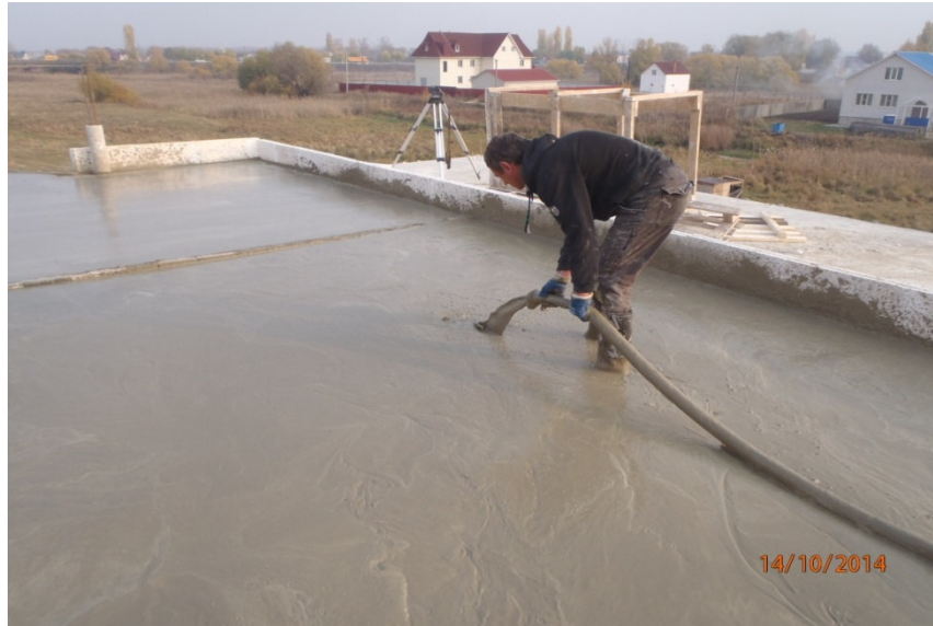
Рис. 4. Заливка перекрытия фиброгипсопенобетоном
