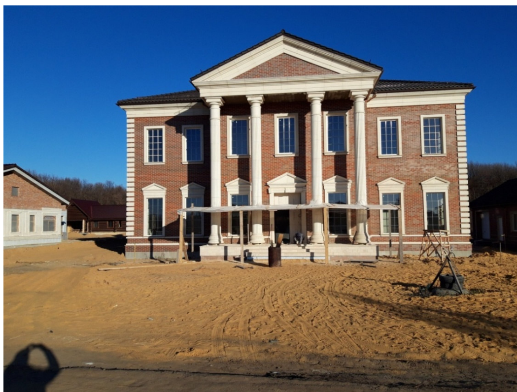
Рис. 5. Возведение коттеджа из фиброгипсопенобетона
