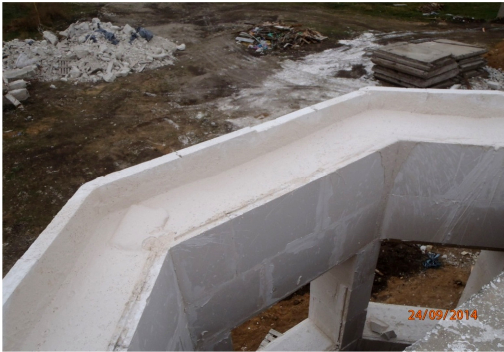
Рис. 2. Совмещение технологии монолитного строительства с возведения зданий из мелкоштучных строительных материалов
