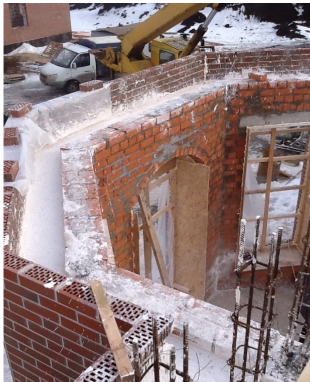
Рис. 3. Совмещение технологии монолитного строительства с возведения зданий из мелкоштучных строительных материалов
