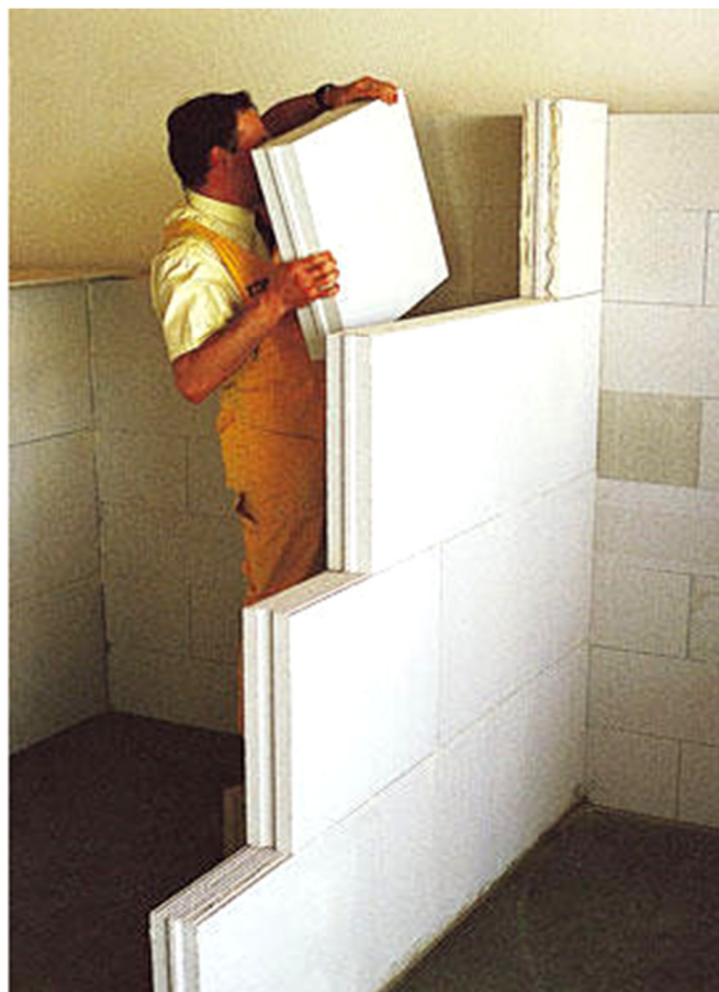
Рис. 1. Монтаж перегородочных панелей
