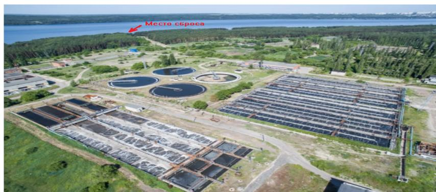
Рис. 1. Левобережные очистные сооружения: фактическая производительность свыше 60 тыс. кубометров в сутки (стрелкой указано место сброса условно очищенных вод)
