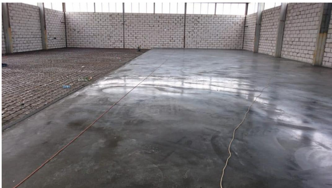
Рис. 1. Бетонный пол с нанесенным топпингом
