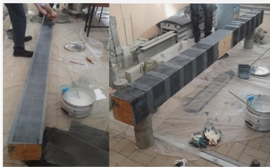
Рис. 10. Внешнее армирование цельного деревянного бруса УВ лентой
