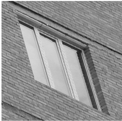
Рис. 5 (фото 5). Общий вид оконного проема здания
