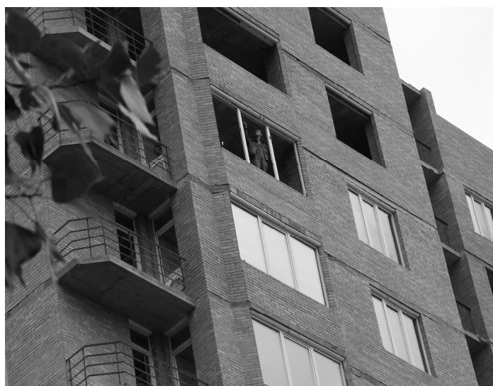
Рис. 4 (фото 4). Монтаж оконных блоков при использовании галтелей из ФПБ
