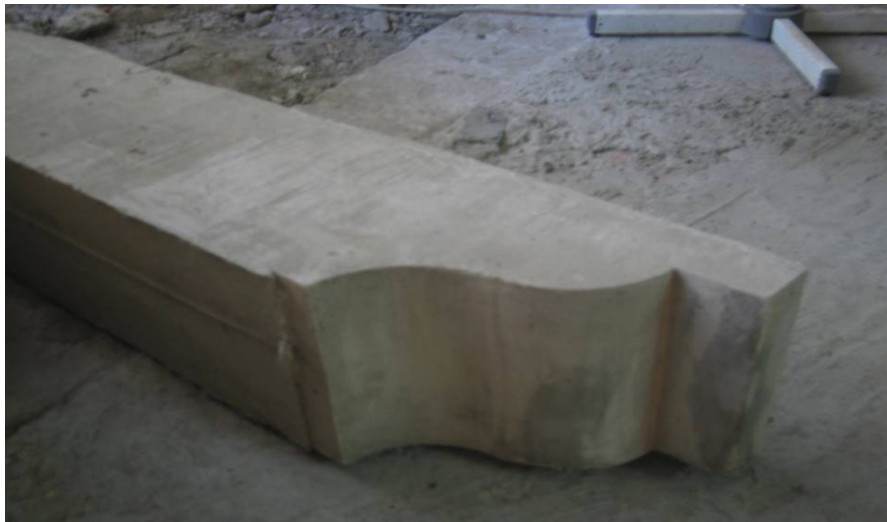
Рис. 6 (фото 6). Карнизный элемент из фибропеножелезобетона плотностью 600 \text{ кг/м}^3 до установки в конструкцию стены
