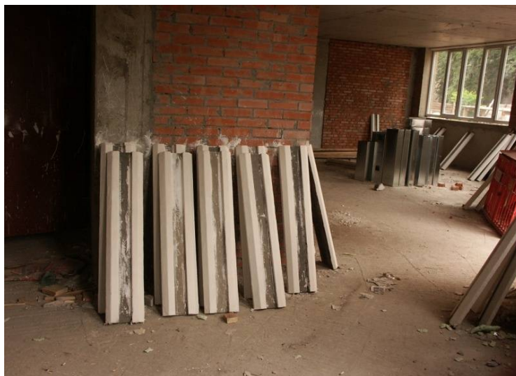
Рис. 3 (фото 3). Оконные галтели после шпатлевания и окрашивания перед установкой их в рабочее положение
