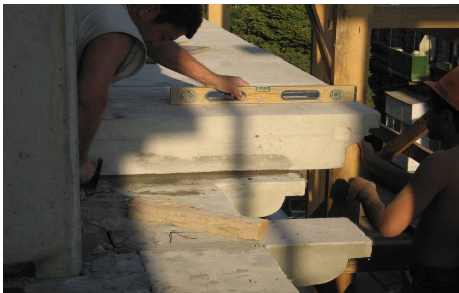
Рис. 7 (фото 7). Монтаж карнизов при возведении офисного здания «Купеческий двор» (квартал Семашко-Серафимовича-Газетный)
