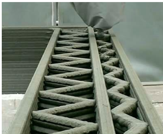
Рис. 1. Наружная стена в процессе 3D печати
