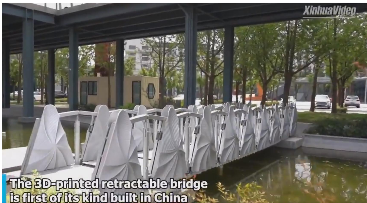
Рис. 2. Перекидной мост, созданный с 3DP в Китае
