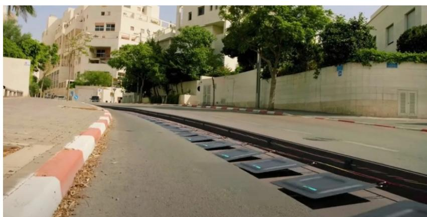
Рис. 4. Визуальное представление расположения пластин под проезжей частью
