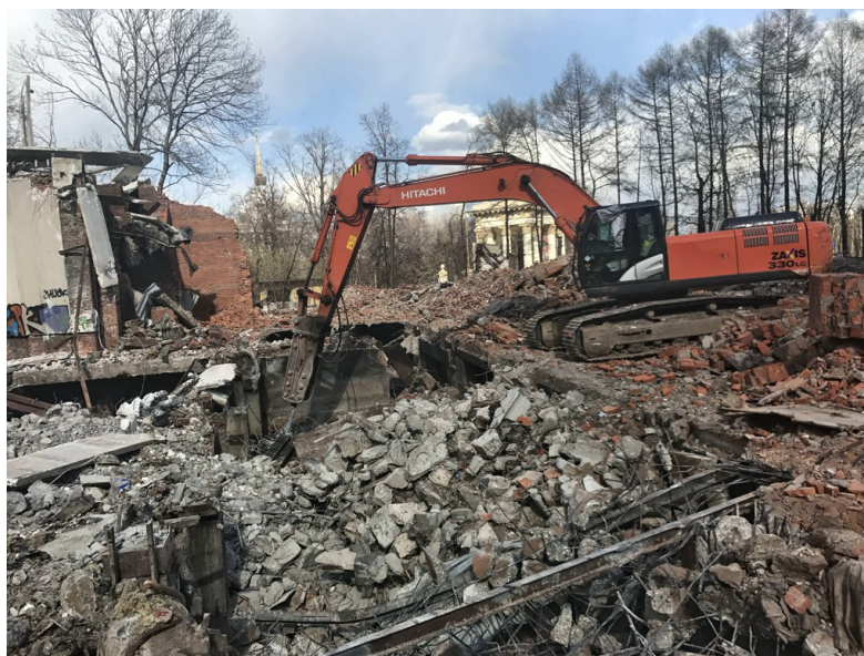
Рис. 3. Строительный мусор, образовавшийся в результате сноса здания
