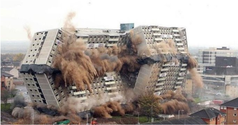
Рис. 1. Взрывной метод сноса зданий и сооружений
