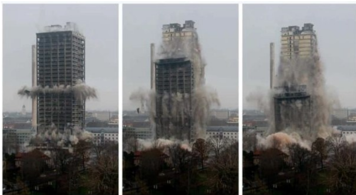
Рис. 2. Снос здания взрывным методом
