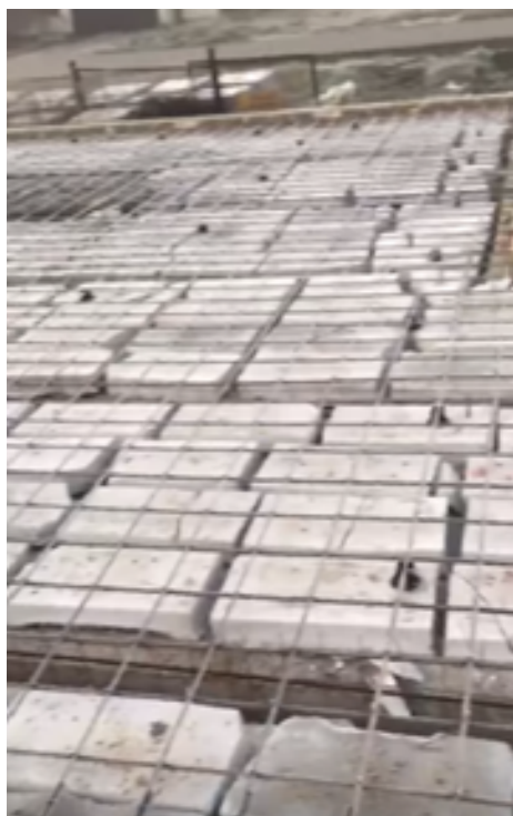
Рис. 2. Плиты перекрытия с шумоизолирующим материалом, накрытым сверху арматурной сеткой
