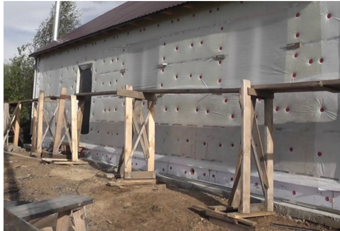
Рис. 9. Повторное использование деревянных материалов в строительных лесах
