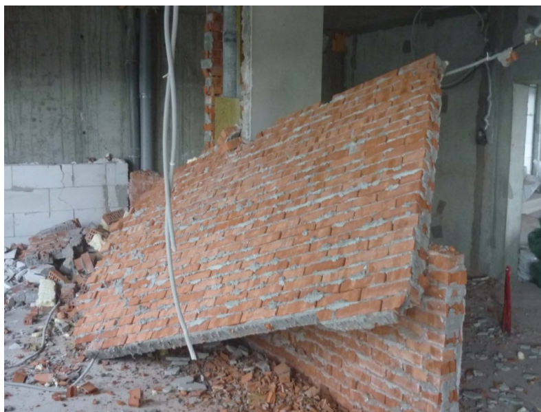
Рис. 6. Демонтаж кирпичных стен
