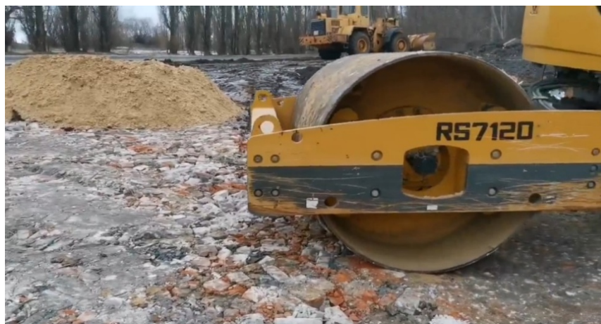
Рис. 2. Механо-гидрохимическая активация боя стеновых каменных материалов современными виброкатками
