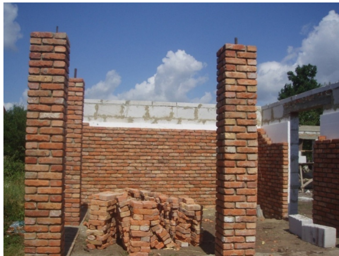
Рис. 12. Облицовка здания б/у кирпичом
