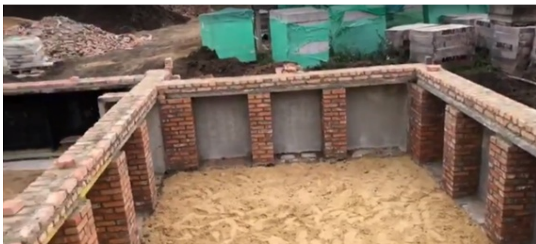
Рис. 7. Устройство сборно-монолитного фундамента из использованных ранее ребристых плит
