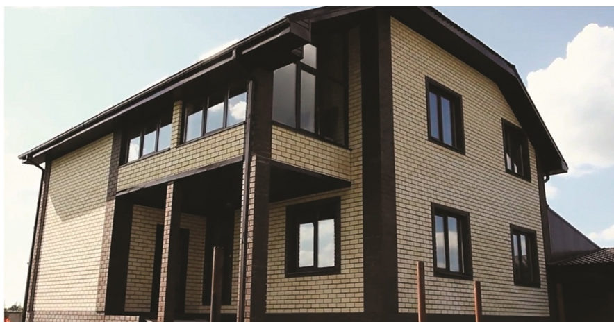
Рис. 5. Дом, построенный из материалов, образовавшихся при поэлементном демонтаже зданий
