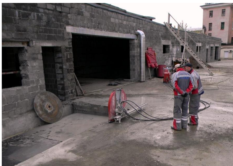
Рис. 4. Применение технологии алмазной резки при демонтаже
