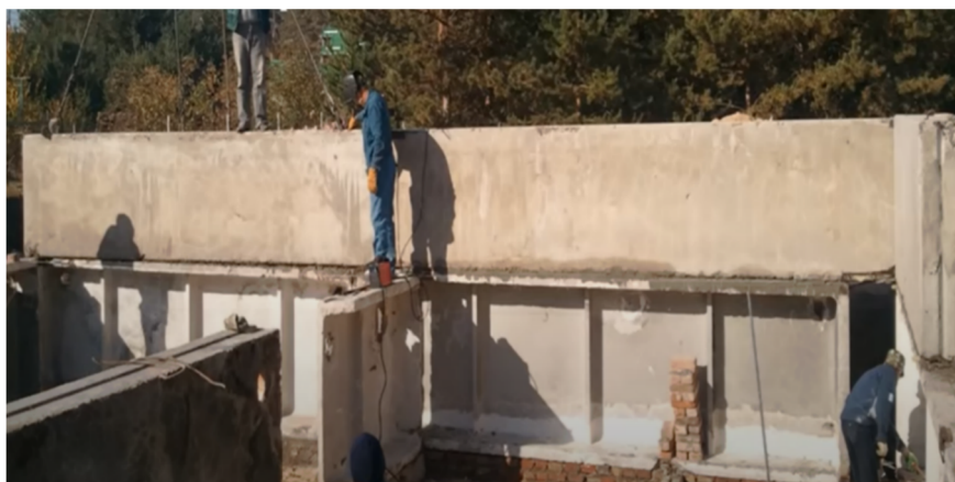
Рис. 4. Возведение стенчатого фундамента с использованием ребристых плит покрытий и керамзитобетонных панелей
