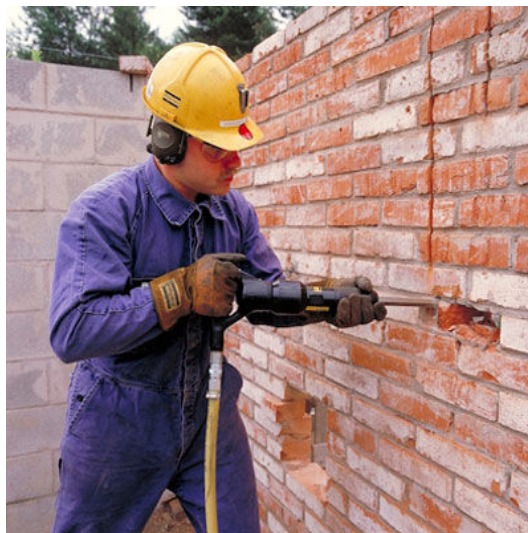
Рис. 2. Ручной метод сноса зданий и сооружений
