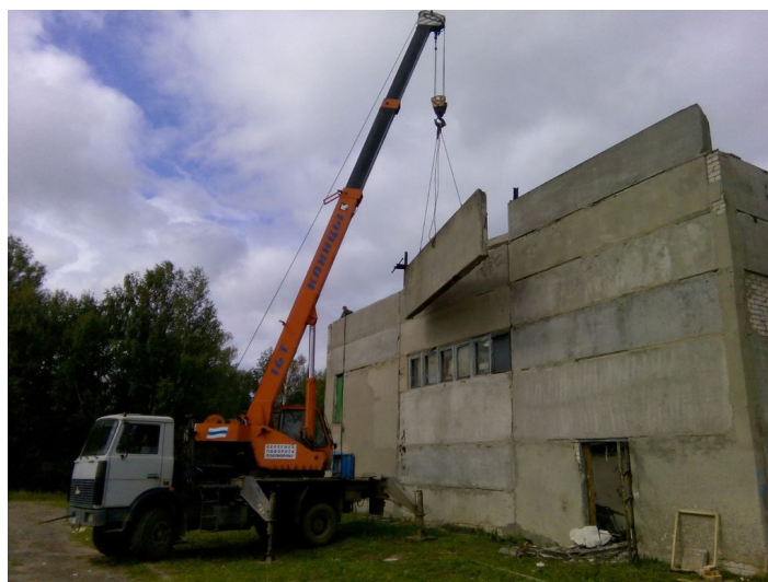
Рис. 4. Поэлементный демонтаж
