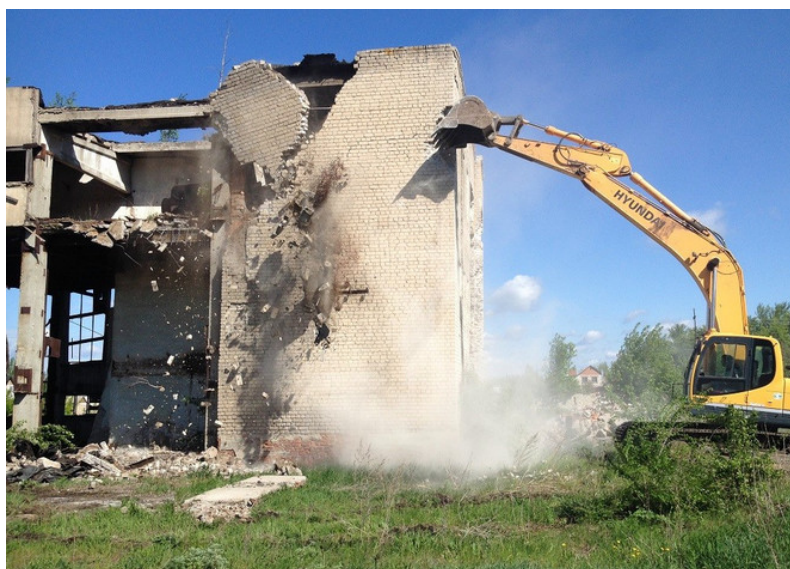
Рис. 1. Снос здания механизированным способом с применением экскаватора
