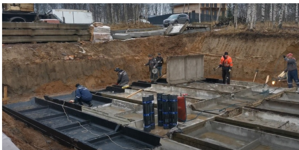
Рис. 7. Устройство сборно-монолитного фундамента из использованных ранее ребристых плит
