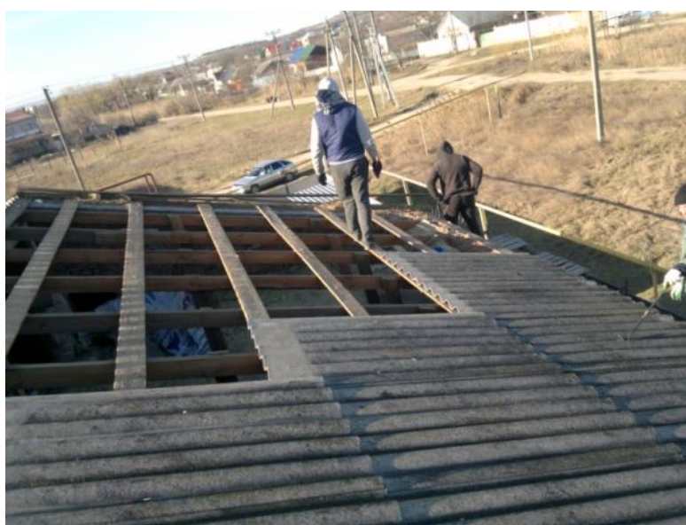
Рис. 5. Демонтаж кровельного покрытия
