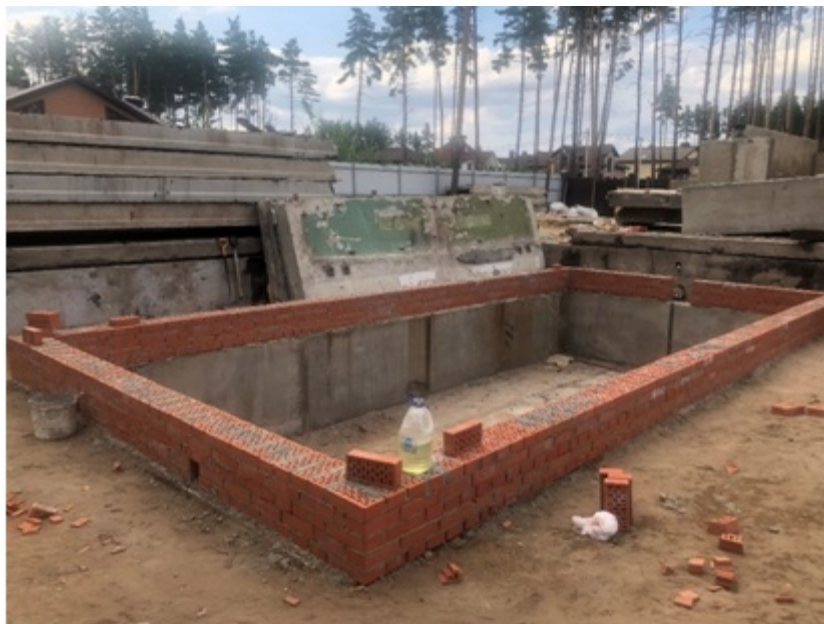
Рис. 3. Фото с объекта строительства
