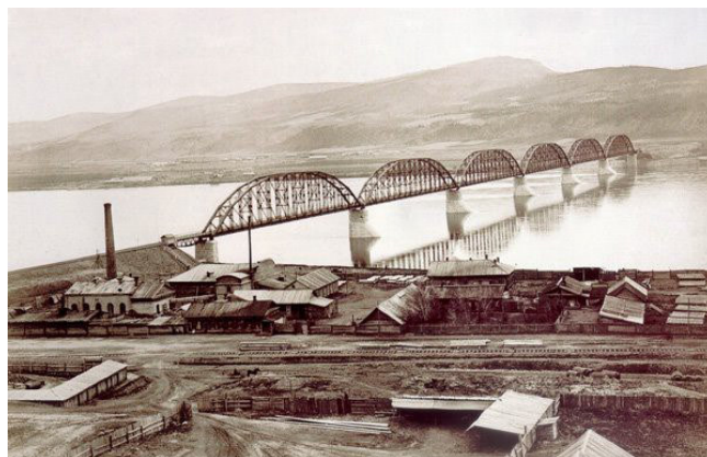
Рис. 2. Железнодорожный мост через Енисей в Красноярске
