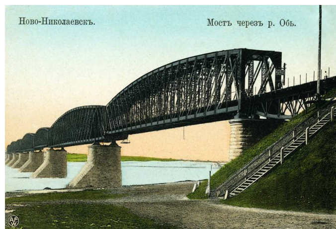
Рис. 1. Мост через Обь на Транссибирской магистрали
