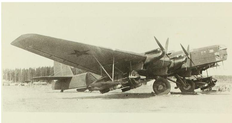
**Рис. 2. Звено Вахмистрова с двумя истребителями И-16 под крыльями**
