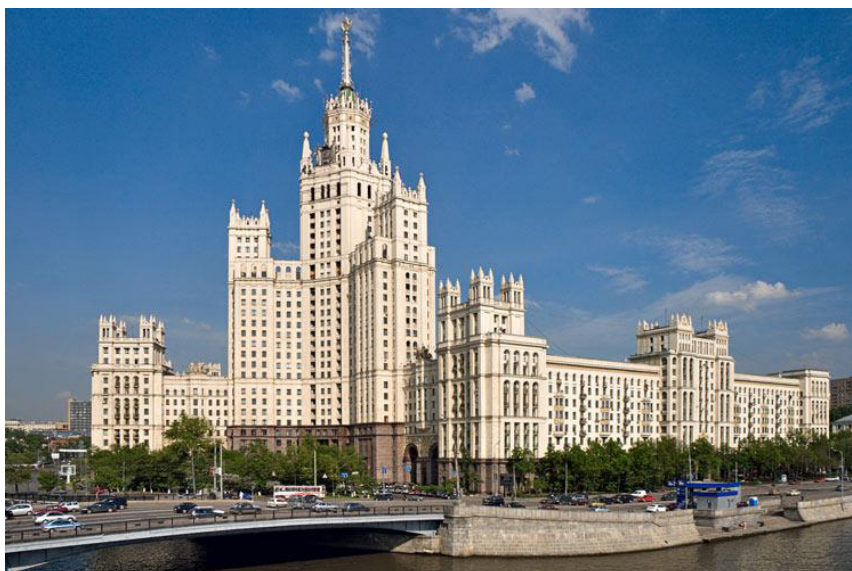
Рис. 16. Жилое здание на Котельнической набережной
