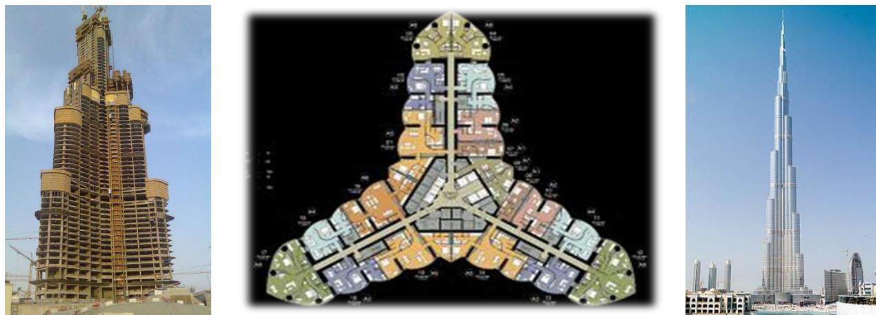
Рис. 2. Небоскрёб Бурдж-Халифа, самое высокое здание в мире, Дубай, ОАЭ, 2010 г.
