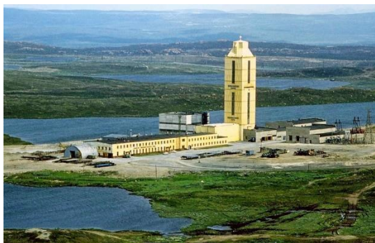
Рис. 1. Территория СГ-3 в период работы
