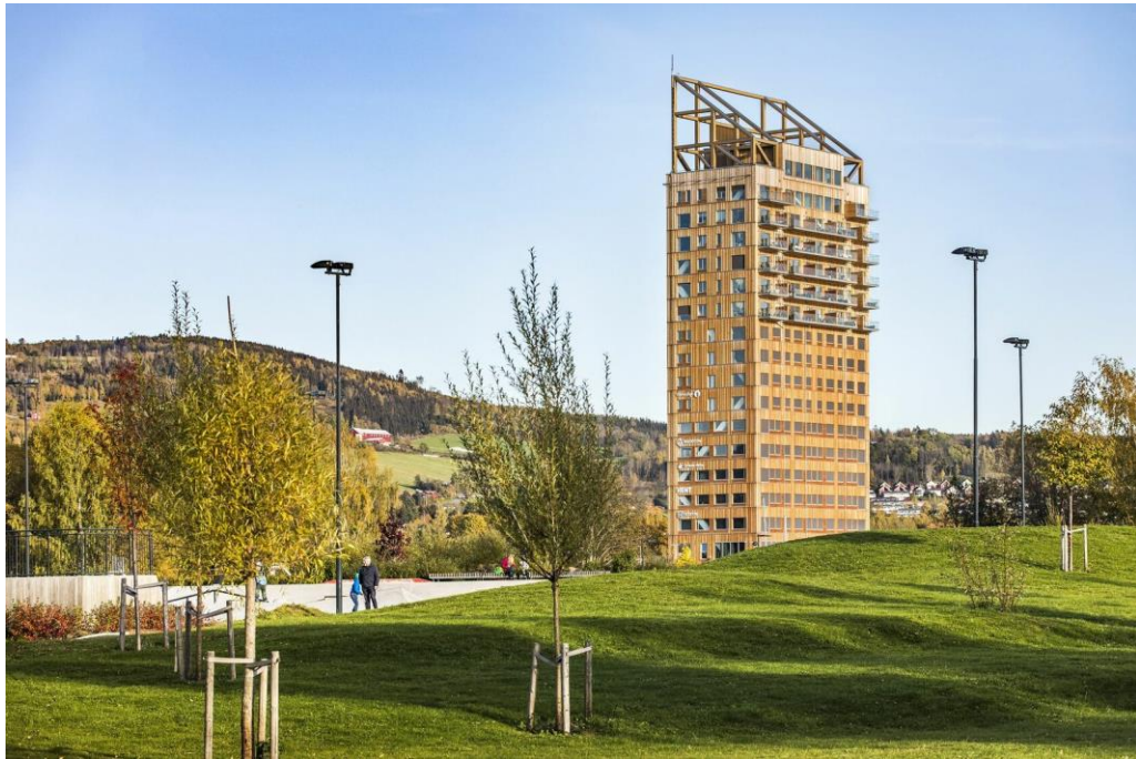
Рис. 1. Башня Mjøstårnet, Брумунддал, Норвегия
