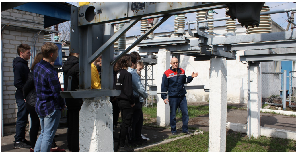
Фото 4. Демонстрация высоковольтного электрооборудования на учебно - тренировочном полигоне.
