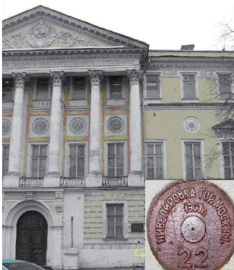
Рис.4.5. Стенной репер
