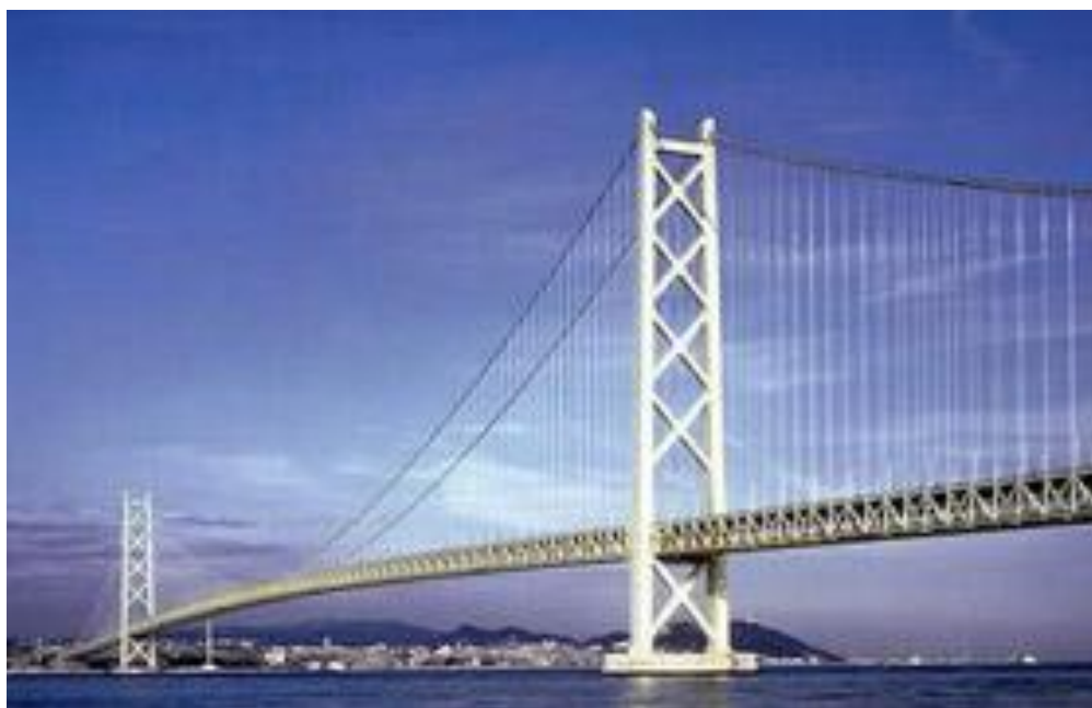
Рис. 2.34. Мост Акаси-Кайкё, Япония
