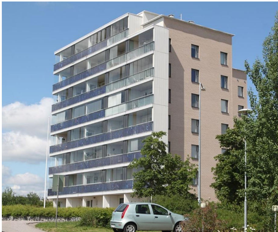
Фото 27. «Salvia» - 6-ти этажное здание с автономным жизнеобеспечением за счет встроенных в ограждающие конструкции фотоэлементов
