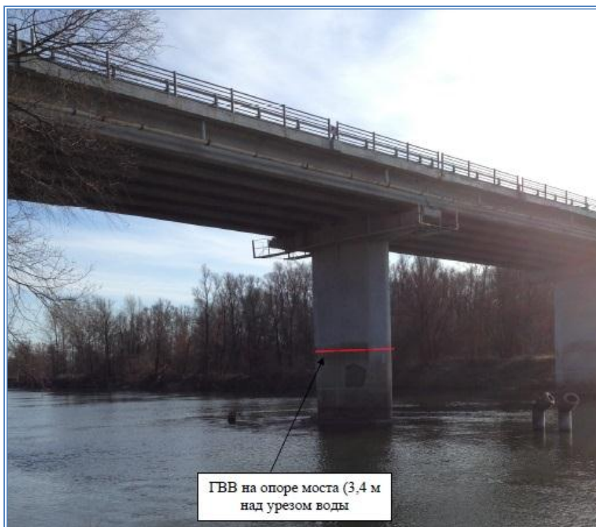
Рис. 2. Река Хопер в створе мостового перехода
