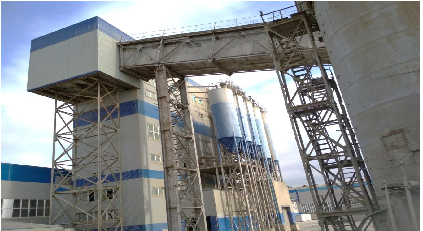
Рис. 28. Примыкание наклонной транспортной галереи к БСЦ
