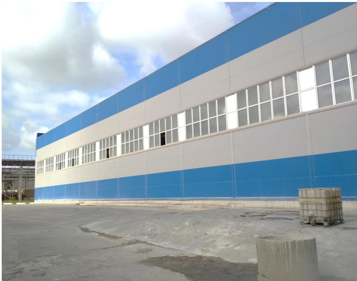
Рис. 44. Внешний вид производственного здания
