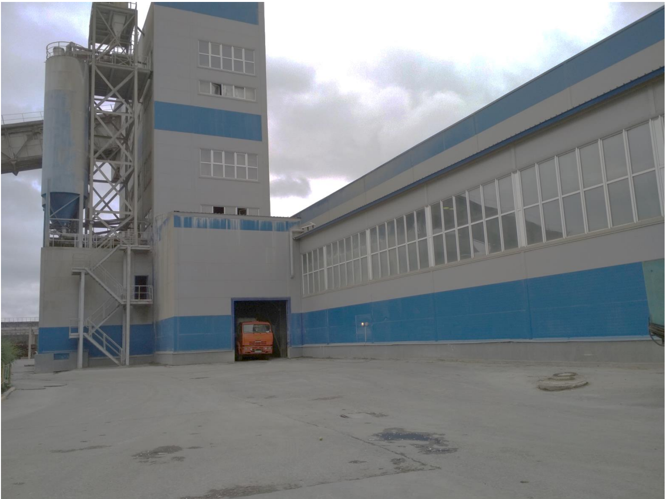
Рис. 26. Примыкание бетоносмесительного цеха к формовочному цеху
