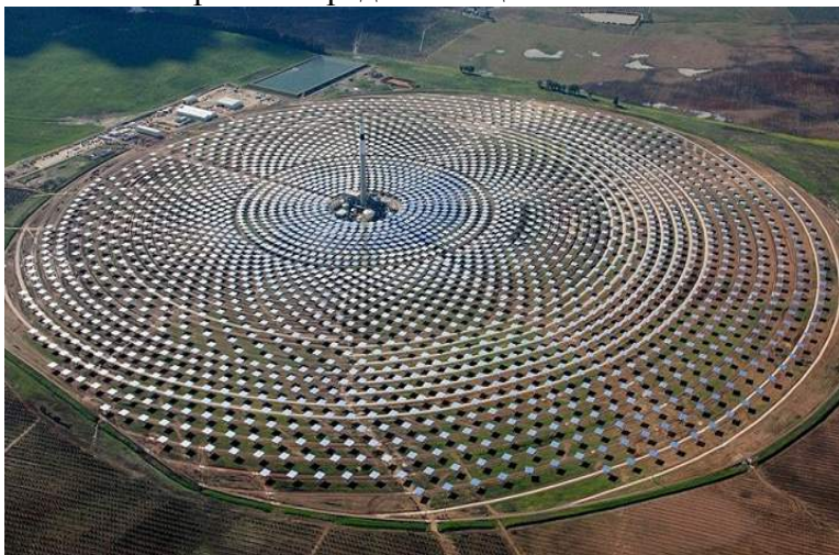
Рис. 4.11. Солнечная термодинамическая электростанция
