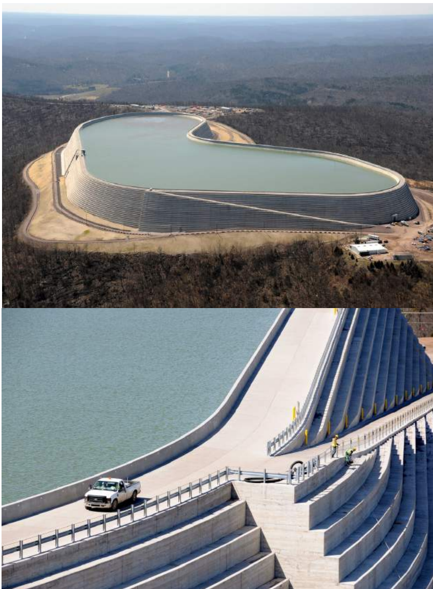
Рис. 4.7 Верховой водоём гидроаккумулирующей электростанции (ГАЭС)
