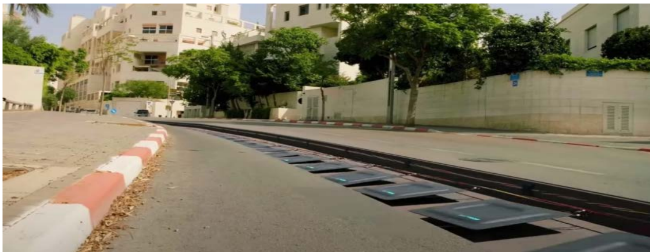
Рис. 2. Визуальное представление расположение медных пластин под ездовым полотном
