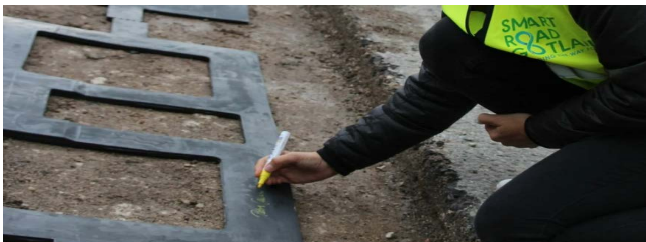
Рис. 1. Процесс установки медных пластин для беспроводной зарядки
