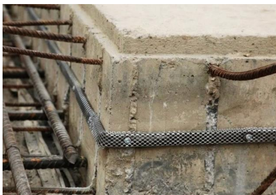
Рис. 5. Монтаж ПНБ (Набухающий бентонитовый профиль)
