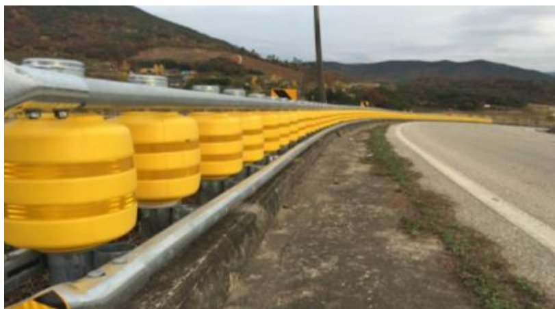
Рис. 1. Роликовое барьерное ограждение, установленное на вираже
