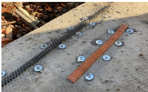
Рис. 6. Крепление ПНБ (Набухающий бентонитовый профиль)
