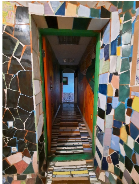
Рис. 8. Выполнение внутренняя отделка из битой плитки
