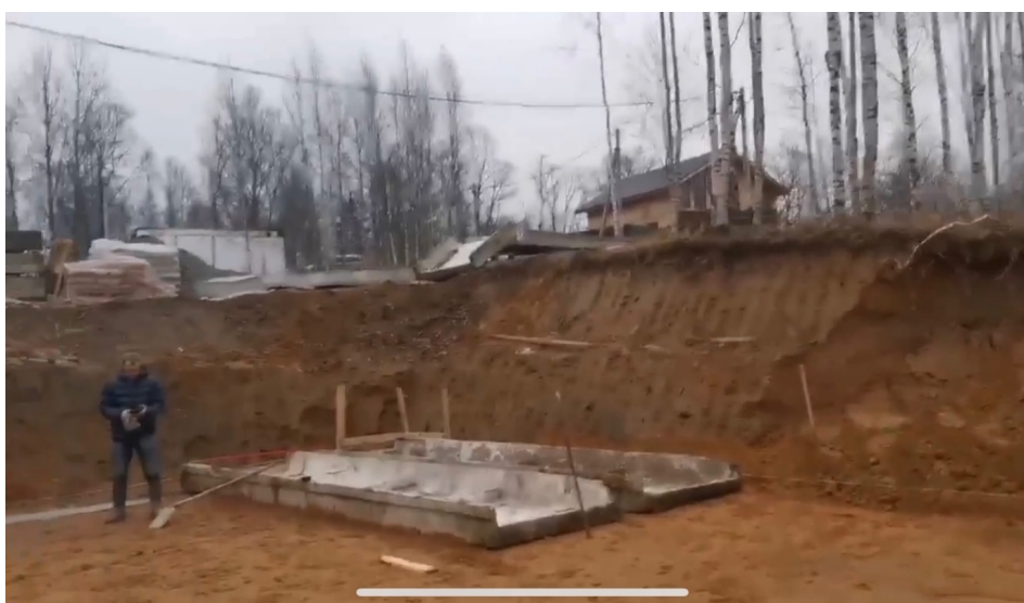
Рис. 5. Устройство укрепления фундаментов по ТЗЦ
