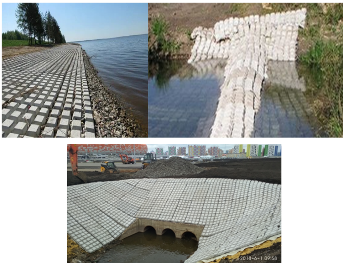
Рис. 1. Защитные сооружения на основе гибких бетонных плит
