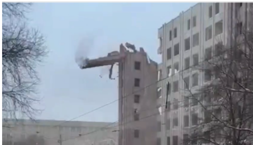
Рис. 2. Механический снос методом обрушения
