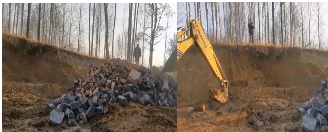
Рис. 4. Устройство укрепления грунтов по ТЗЦ
