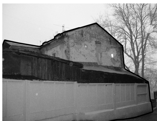
Рис. 9. Торцевой (северный) фасад.
