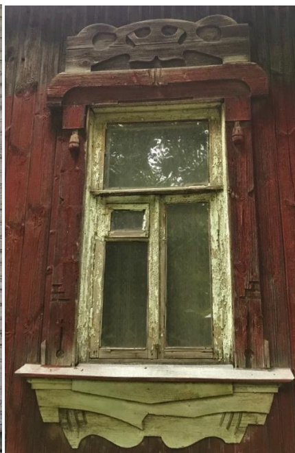
Рис. 4. Дом В.С. Александрова в Рязани (ул. Садовая, д. 6) – деталь: наличник
