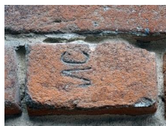
Рис. 2. Фрагмент кирпичной стены в переулке Мельничный в Воронеже
