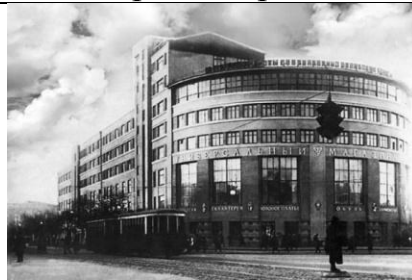
Фото 2. Дом торговли "Утюжок". 1930 г. Архитектор: А.И. Попов-Шаман. Архивное фото 1930-х гг. Воронеж, ул. Проспект Революции, 58. ОКН регионального значения.
