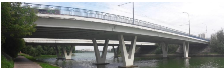
Рис.1. Общий вид верхнего Борисовского моста №1
