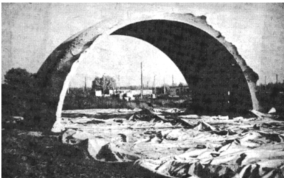
Рис. 3.7. Общий вид фрагмента волнистого свода из стеклофибробетона
