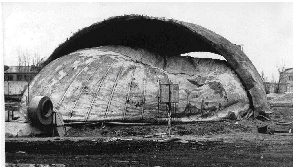
Рис.1.18. Распалубливание армоцементного свода, возводимого на пневмоопалубке
