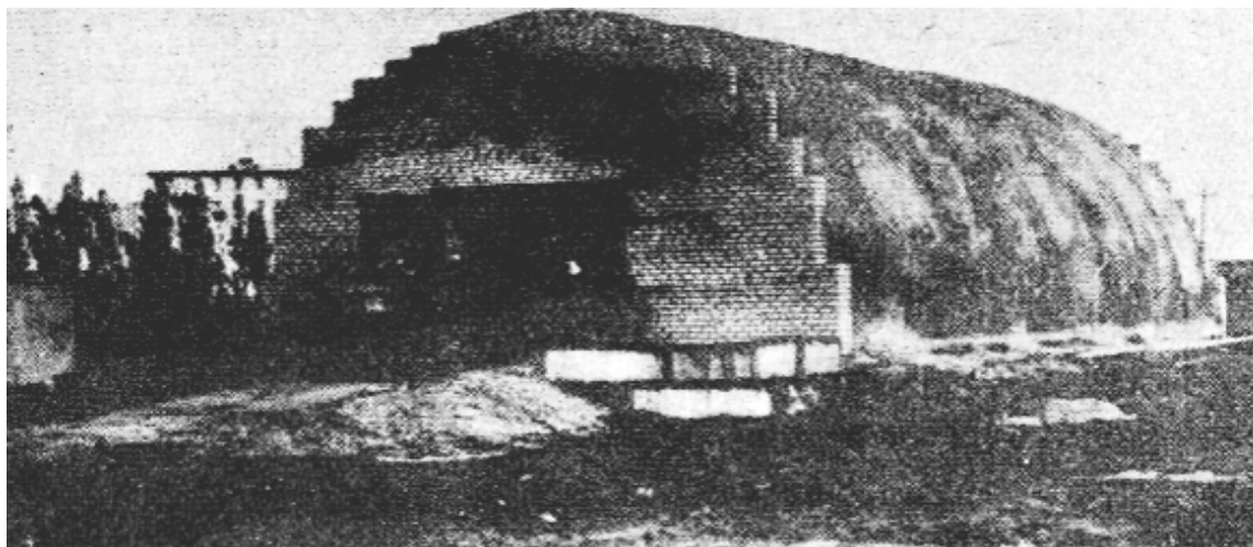
Рис. 3.5. Устройство торцевых ограждений
