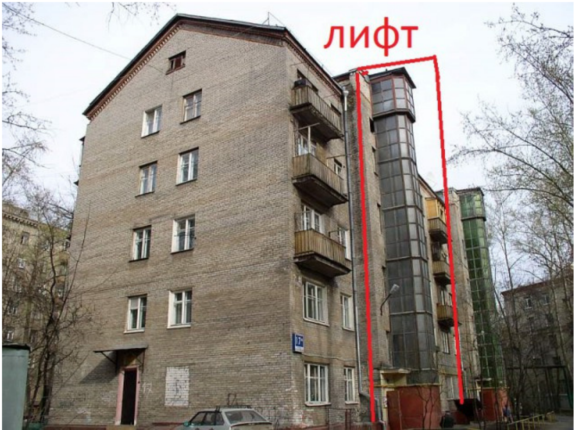
Рис.2. Вариант реконструкции дома (способ №2) (по материалам интернет изданий)
