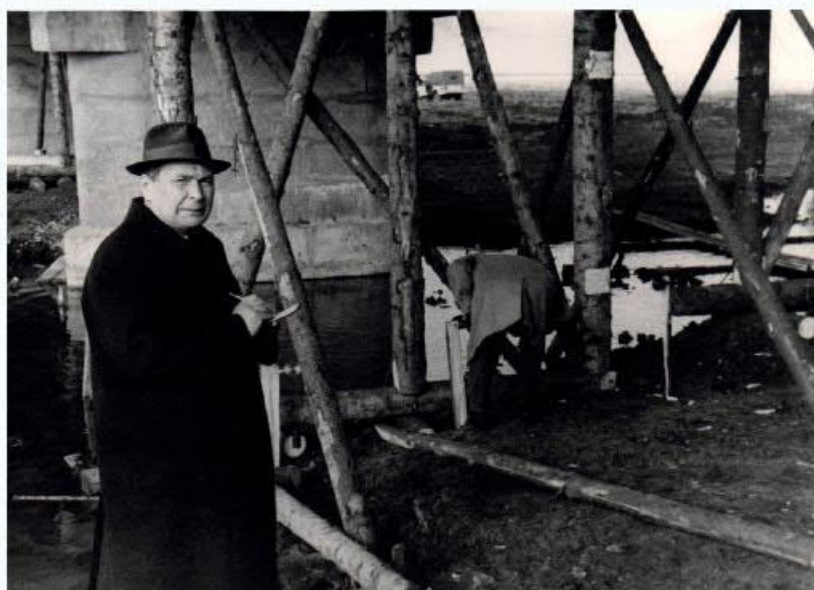
Доктор технических наук, профессор А.М. Иванов на испытании моста с пролетами из клееных деревянных балок через реку Курлак.
