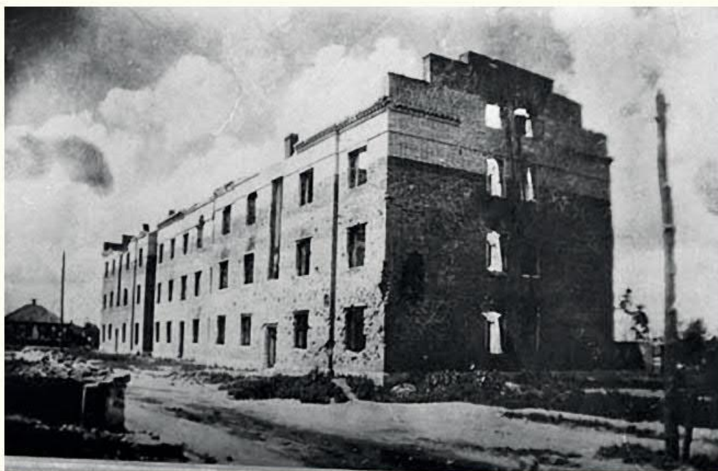
Послевоенное состояние общежития на ул. Гродненской. Фонды Музея инженерного дела.
