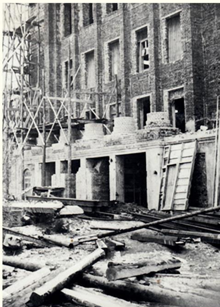
1944 г. Восстановление здания института после войны. Фонды Музея инженерного дела.
