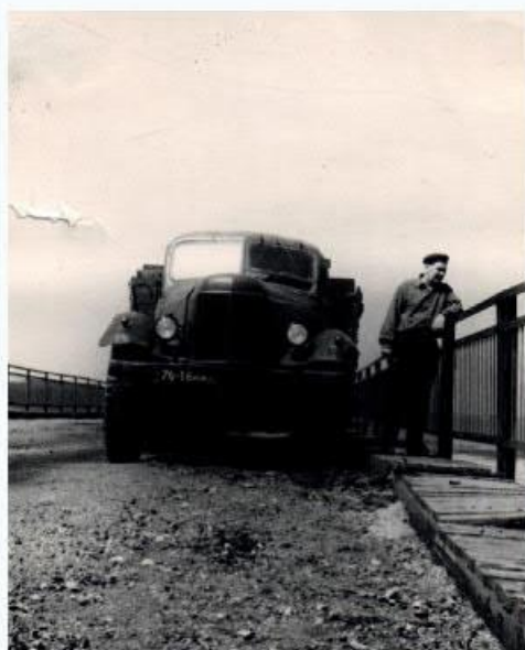
Загрузка моста испытательной нагрузкой в 1950-е гг.
