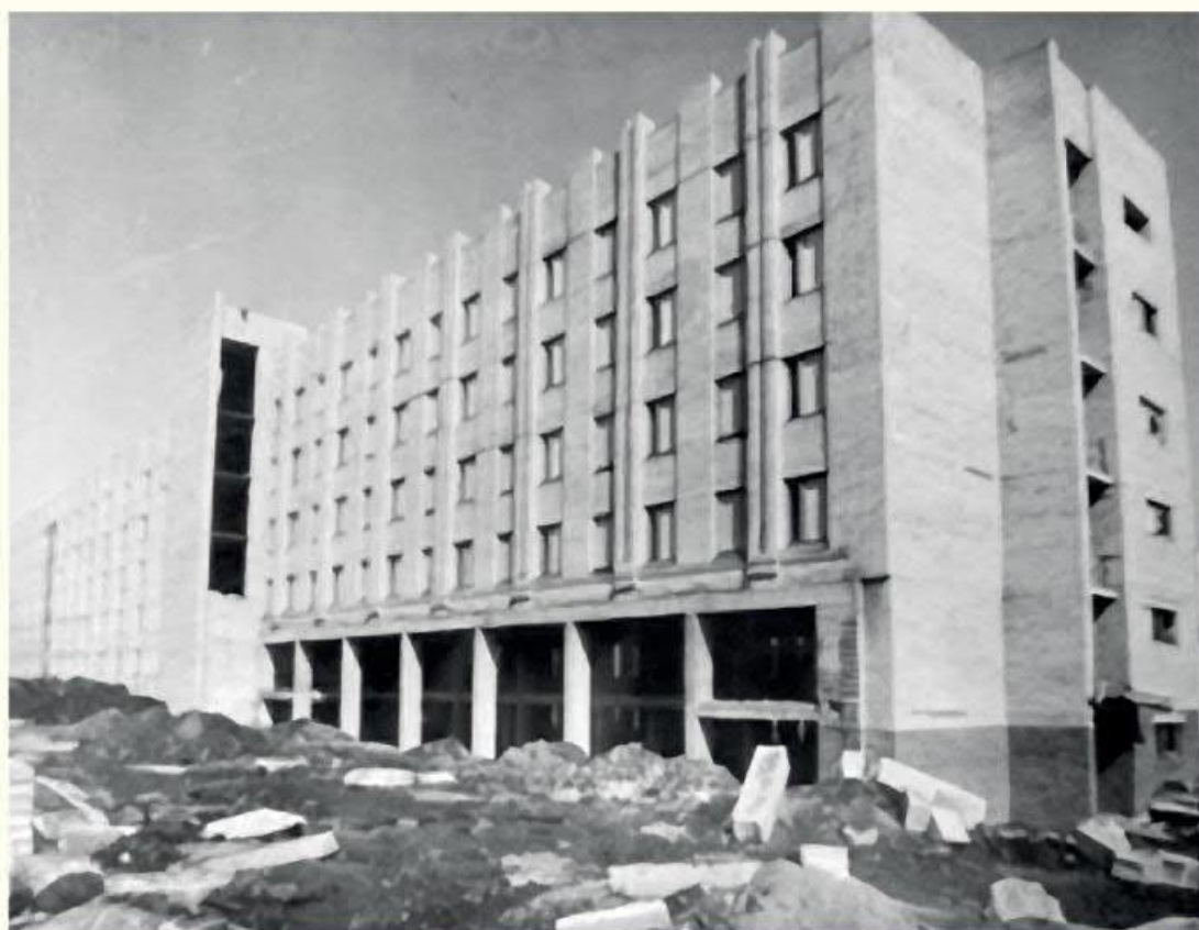
Строительство первого корпуса. 1970-е гг. Фонды Музея инженерного дела.
