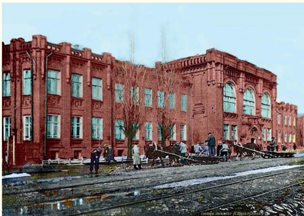
Вид здания в 1920-е гг. 3 реконструкция. Фонды Музея инженерного дела.
