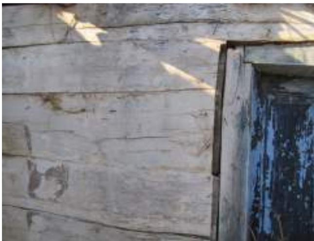
*Фрагмент стены этой хаты платового леса, т.е. пиленные плахи, внутри стены не обмазаны глиной, а мытые.*
