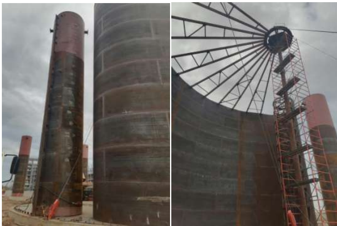
Рис. 2. Монтаж основного конструктива резервуаров (промежуточные этапы монтажа)
