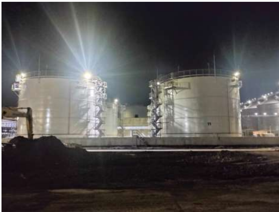
Рис. 1. Общий вид четырех вертикальных стальных резервуаров РВС-4950 м 3
