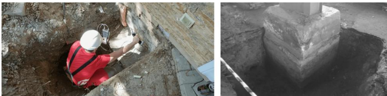
Рис. 2. Выполнение работ строительно-технической экспертизы методом вскрытия
