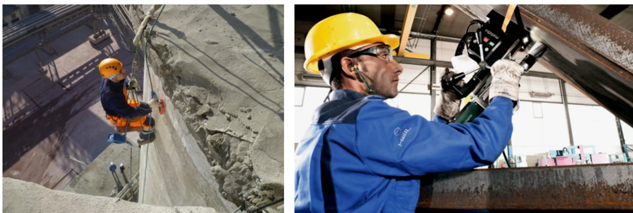
Рис. 1. Проведение работ по выполнению строительно-технической экспертизы
