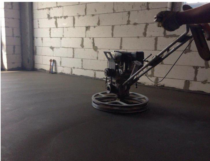
Рис. 2. Стяжка пола механизированным способом
