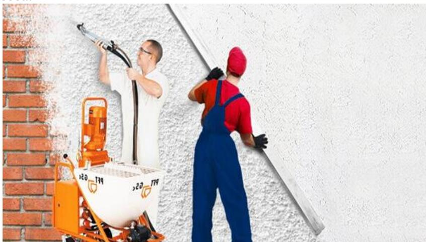
Рис. 1. Ручной и механизированный способ оштукатуривания стен
