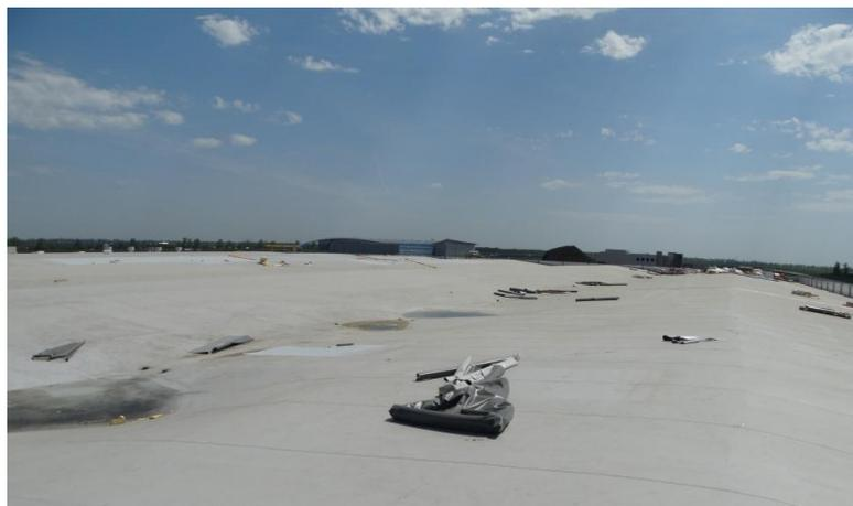
Рис. 1. Скопления воды в местах обрушения настила
