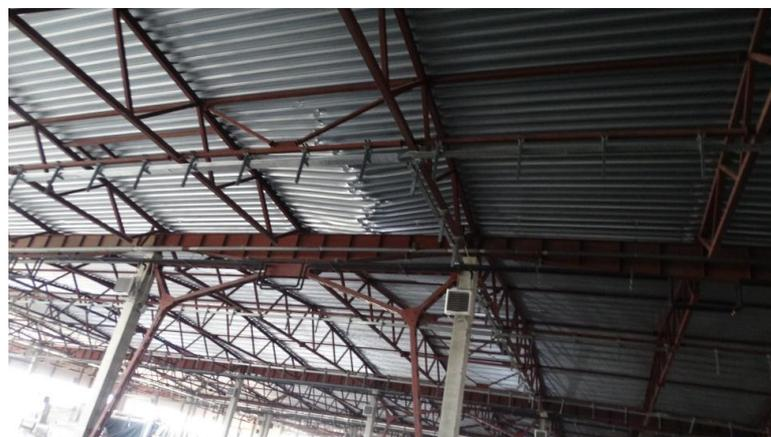
Рис. 2. Истощение несущей способности настила в середине пролёта
