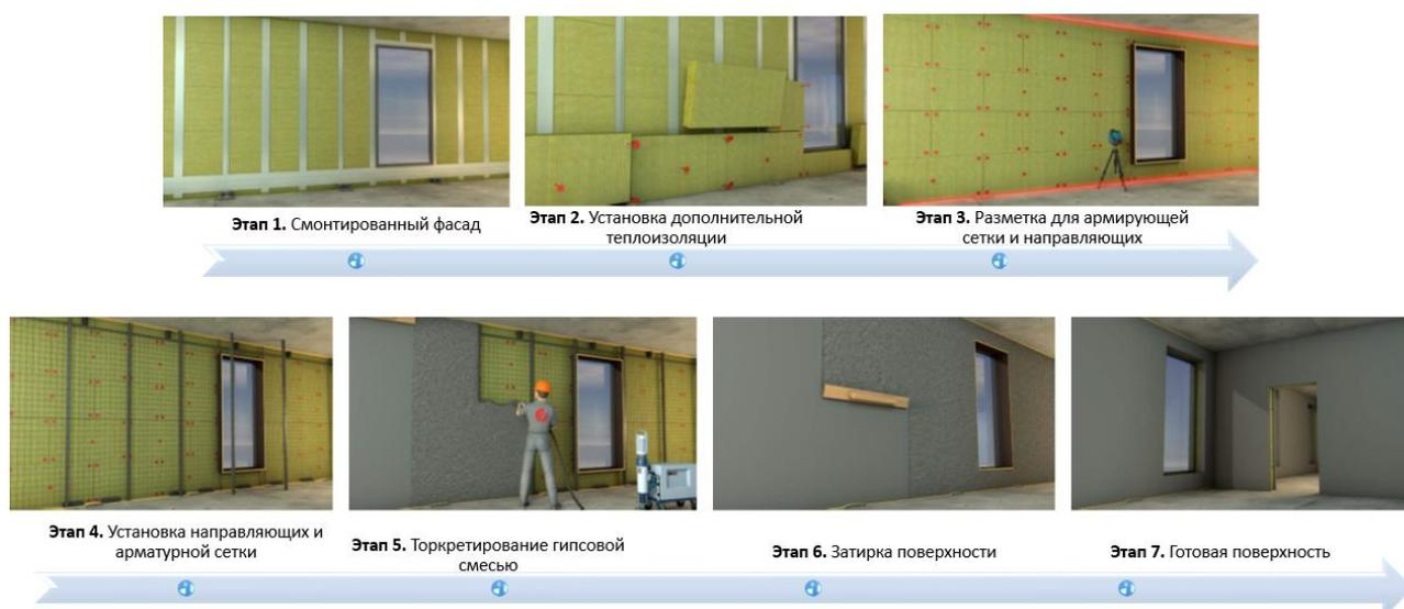
Рис. 4. Технологический процесс устройства ограждающей стеновой конструкции
