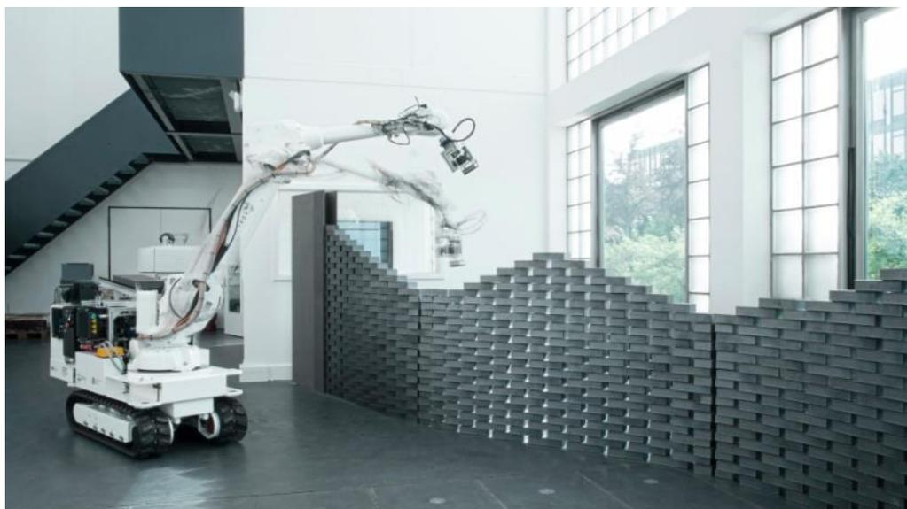
Рис. 3. Робот-каменщик In-Situ Fabricator
