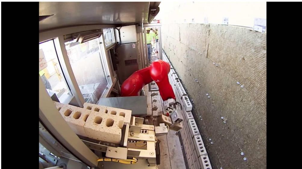
Рис. 1. Укладка кирпича роботом-каменщиком SAM100
