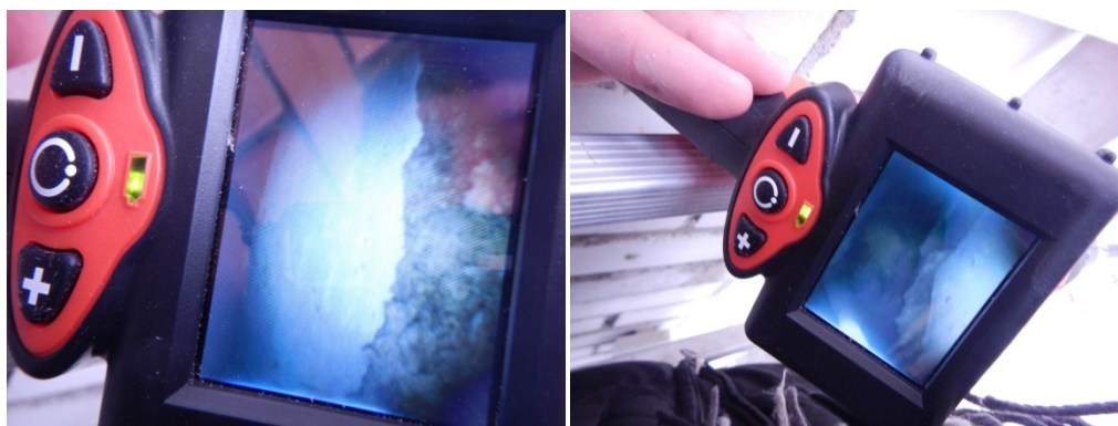
Рис. 4. Исследование внутреннего слоя стен с помощью эндоскопа
