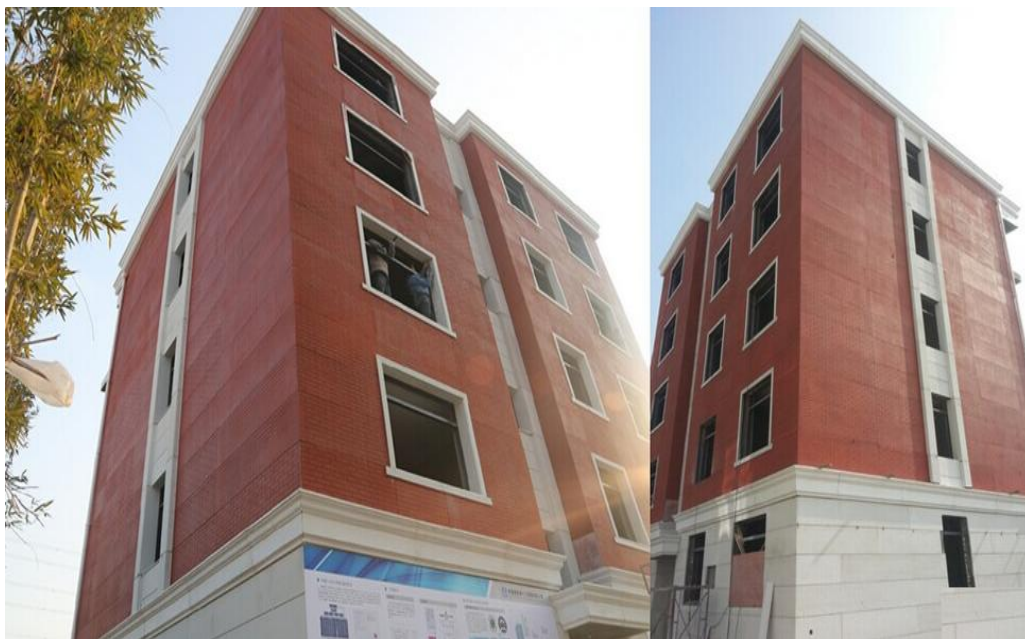
Рис. 1. Пятиэтажный дом, напечатанный принтером компании «Shanghai WinSun Decoration Design Engineering Co.» в Шанхае
