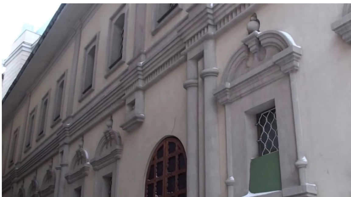
Рис. 1. Боярские Палаты в Москве. Воссоздание из пенополистирола древней архитектуры
