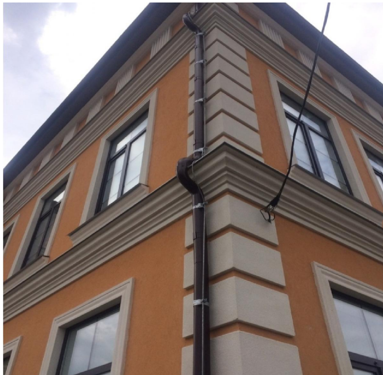
Рис. 4. Защитные отливы для сильно выступающих декоративных элементов из пенополистирола
