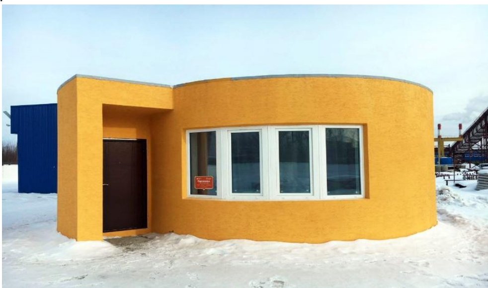
Рис. 5. Дом площадью 38 м 2 , Московская область, территория Ступинского завода ячеистого бетона
