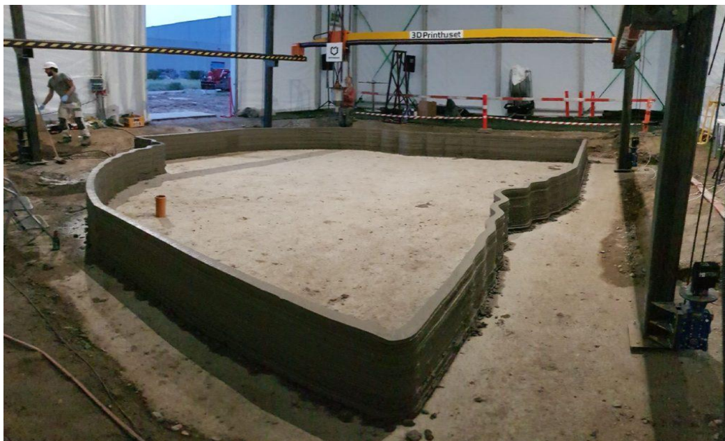
Рис. 3. Портальный принтер; фрагмент процесса возведения
