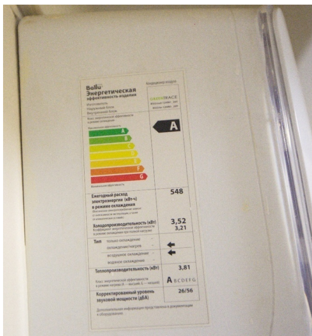
Рис. 4. Палаты интенсивной терапии, 2 этаж. Установлены кондиционеры заниженной мощности.
