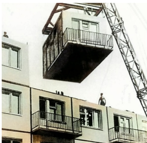
Рис. 4. Строительство модульного дома в СССР
