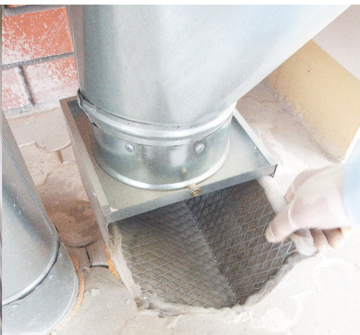
Рис. 5. Отделение интенсивной терапии. Установлены фильтры, не соответствующие нормативным документам.
