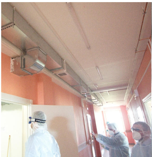
Рис. 2. Общий коридор 5 этажа, коридор 5 этажа, дверь в приточную камеру – нет разделения на "грязную" и "чистую" зоны. Аналогично 2, 3, 4 - этажи.
