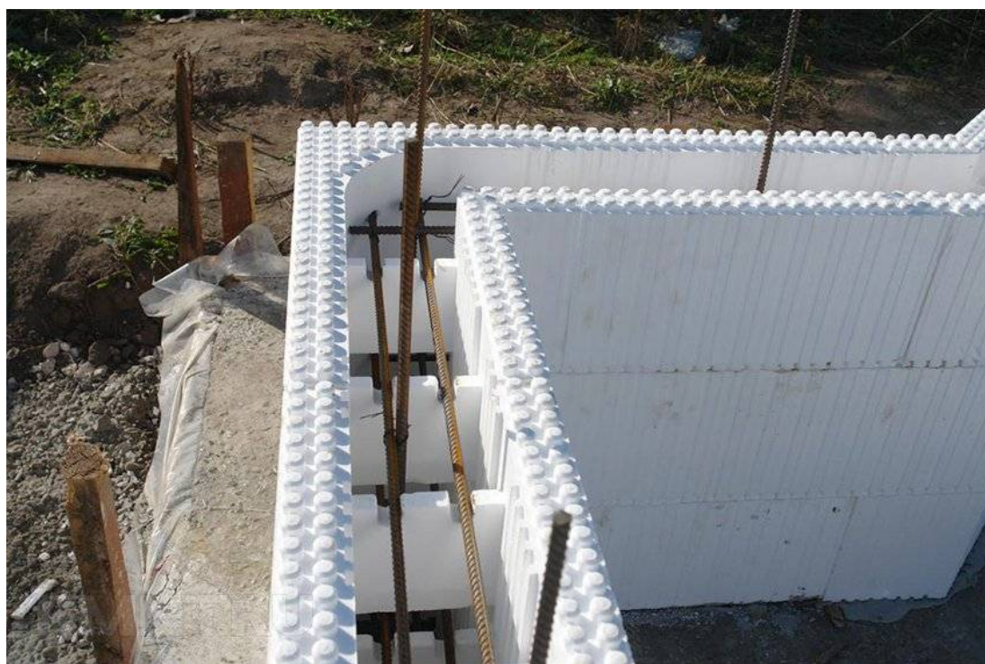
Рис. 2. Опалубка из пенополистирола
