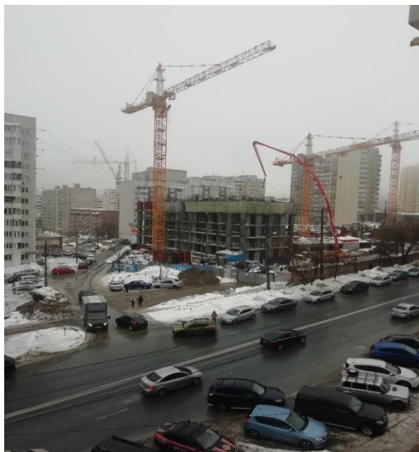
Рис. 5. Возведение монолитного здания
