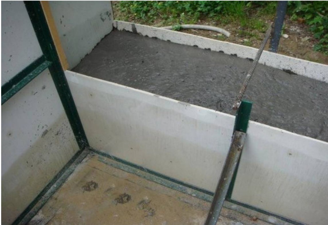
Рис. 4. Опалубка из стекломагнезита
