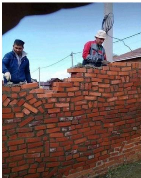
Рис. 6. Ошибки при выполнении укладки кирпича
