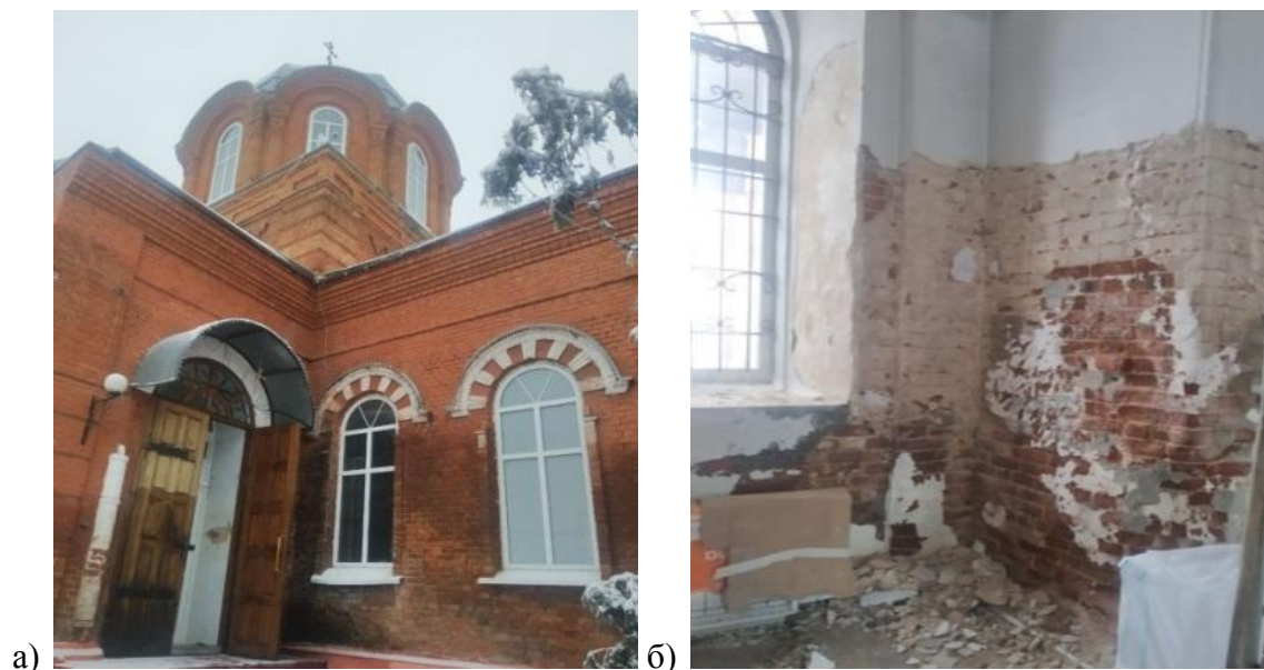
Рис. 3. Современное состояние храма святителя Тихона Задонского: а) фасад храма с северной стороны, вход в храмовую часть; б) состояние красного кирпича кладки стен внутри храма (фото авторов)
