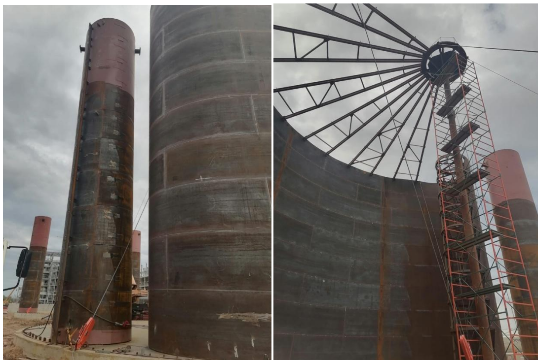
Рис. 2. Монтаж основного конструктива резервуаров (промежуточные этапы монтажа)
