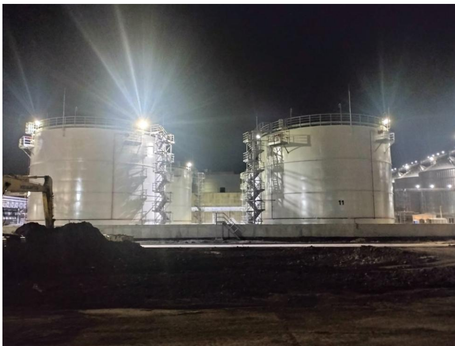
Рис. 1. Общий вид четырех вертикальных стальных резервуаров РВС-4950 м 3
