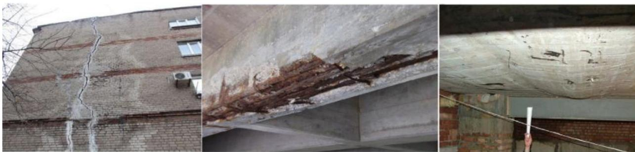
**Рис. 2. Дефекты строительных конструкций (трещины, коррозия, деформация)**
