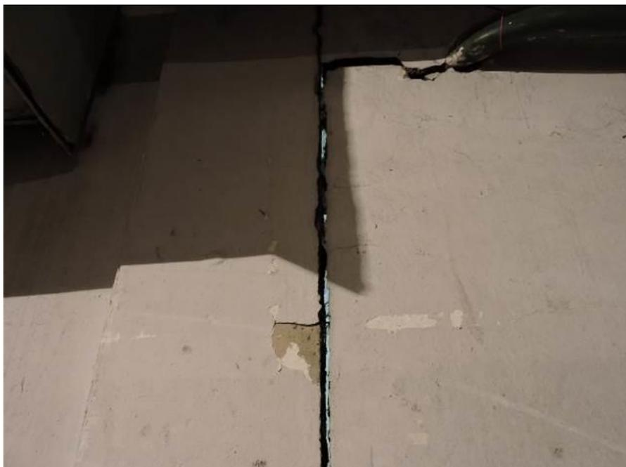
**Рис. 3. Вид на узел примыкания перегородки к колонне каркаса**
